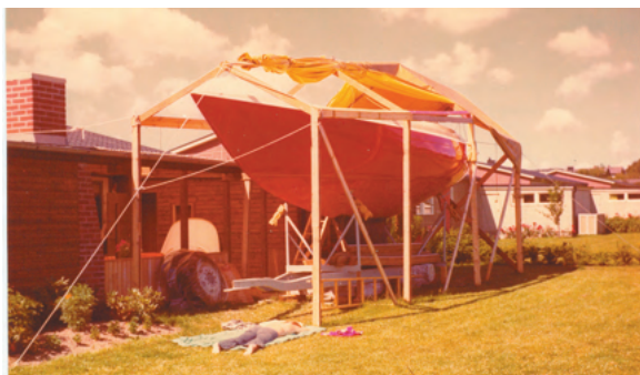
Fjärde båten, B31 byggdes bakom huset jun74-jun75 under ställning och presenning som surrades i skorsten.
